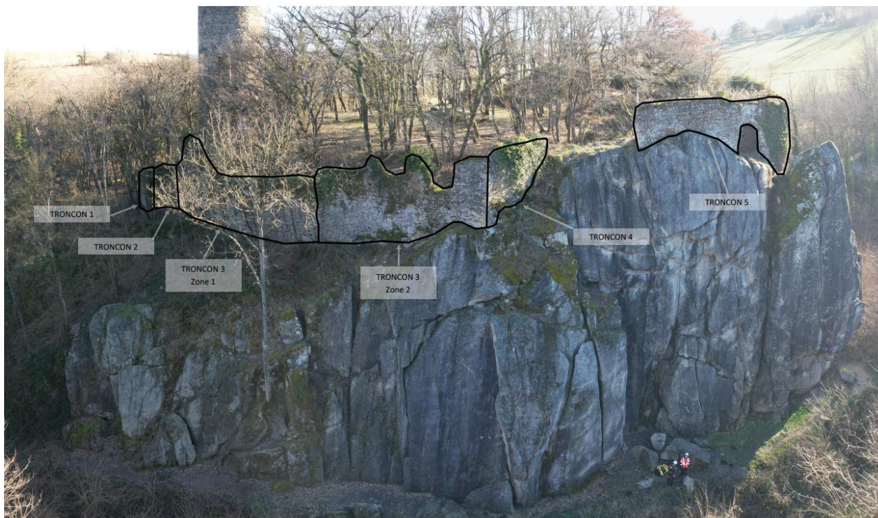
Figure 7 : Définition des tronçons sur vue aérienne (source Géolithe)
